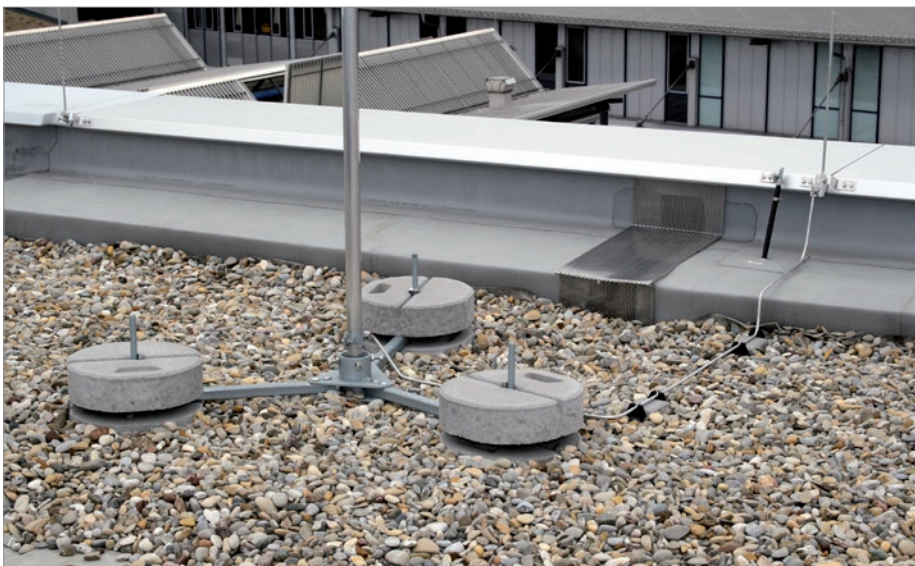
Rys. 1. Przykład montażu masztu na statywie – obciążenie dodatkowe (oprócz ciężaru samego masztu i statywy) stanowi 6 obciążników betonowych o wadze 17 kg każdy
