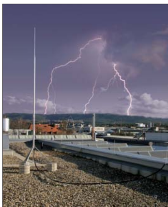
Obr. 2. Instalace vodiče HVI power
