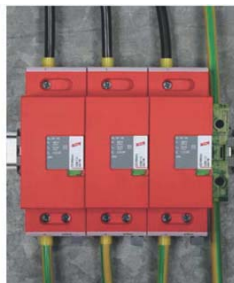
Upevnění jednoduchým navcuknutím na montážní lištu.
