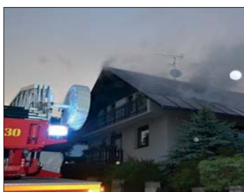
Obr. 5. Požár rodinného domu po úderu blesku do antény
