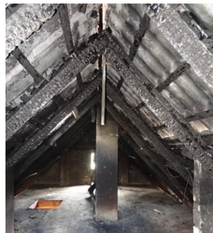
Foto: Požár po úderu blesku do kovové střešní krytiny
