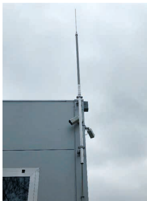
Obr. 17. Ukotvení podpůrné trubky pro HVI long držáky na stěnu
