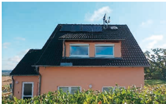
Obr. 1. Nevhodný neizolovaný hromosvod
