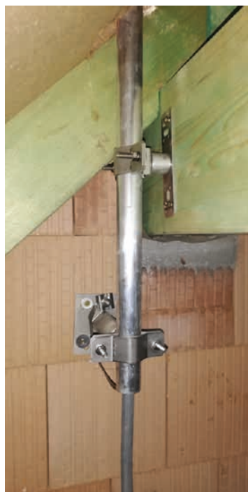
Obr. 12. Ukotvení podpůrné trubky DEHNcon-H držáky na stěnu
