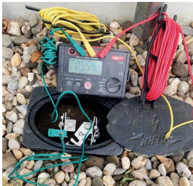
Obr. 4. Měření izolačního odporu
