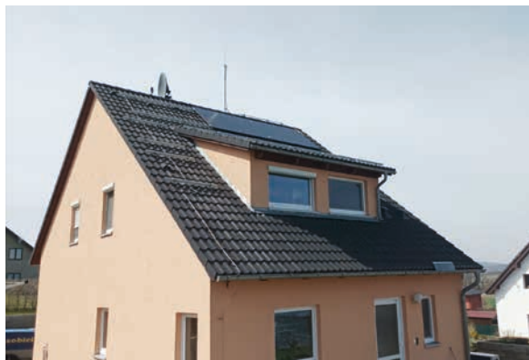
Obr. 2. Správně realizovaný izolovaný hromosvod
