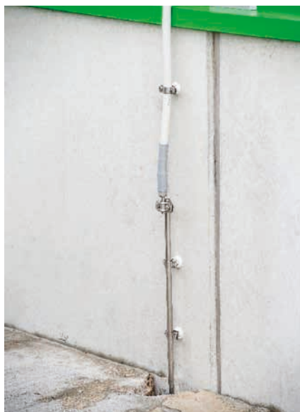
Obr. 19. Zkušební svorka a zaváděcí tyč
