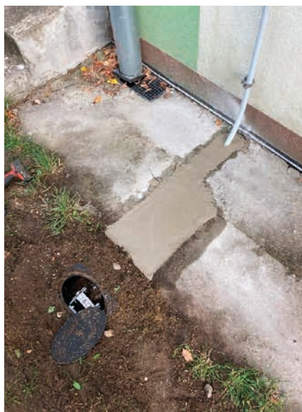
Obr. 18. Zemní litinová krabice povrchové/skryté provedení
