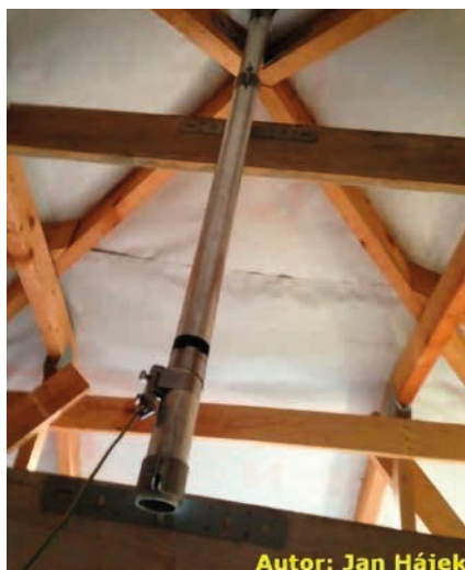
Obr. 5. Kotvení na trámové držáky na stěnu
