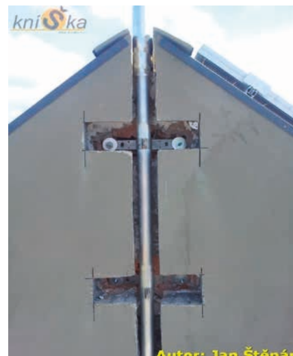
Obr. 6. Kotvení do štítu držáky na stěnu
