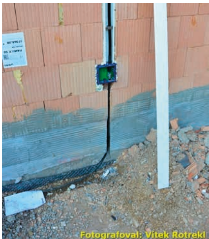
Obr. 1. Vodič HVI uložený v kabelovém žlabu
