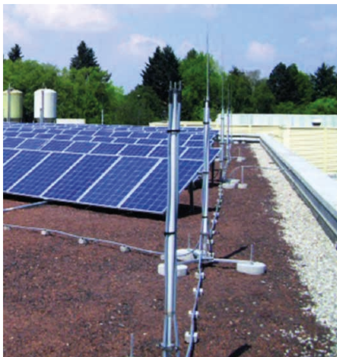
Obr. 11. Jímací stožár 30/50 pro vodiče HVI light
