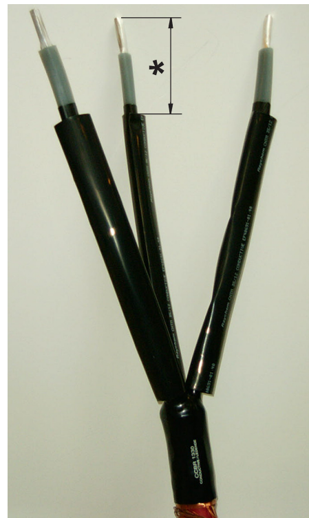
KKSI vist med isolationsskærmen fjernet til 20 mm fra krympeslangen og klar til montage.
